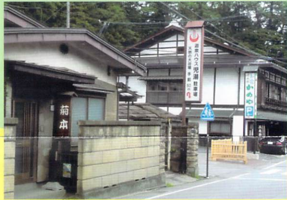
下諏訪宿本陣,問屋場跡
